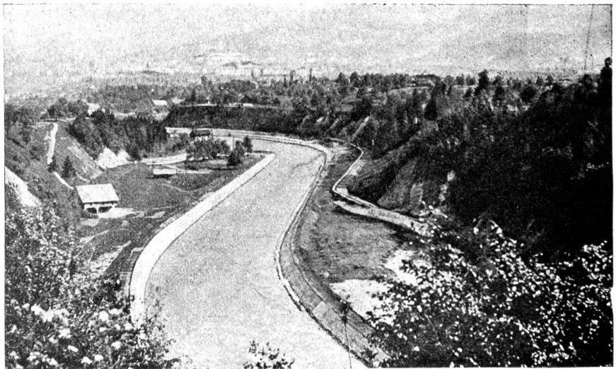
Die Muotakorrektio. Abb. 19. Korrektionsstrecke oberhalb Hinter-Ibad. August 1913.
