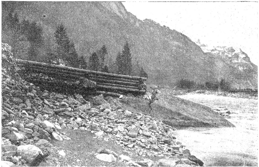
Die Muotakorrektio. Abb. 17. Holzsporren mit Betonkopf.
