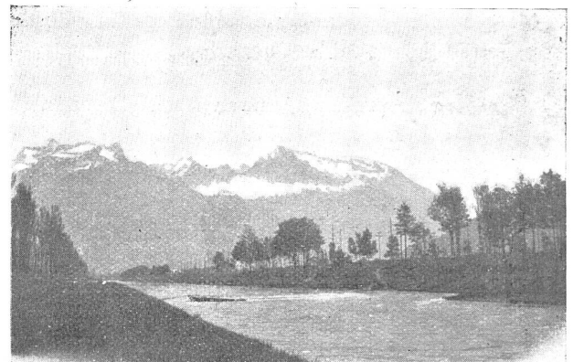
Unterbrechung der Schifffahrt im Linthkanal. Das gesunkene Schiff von unten gesehen.
