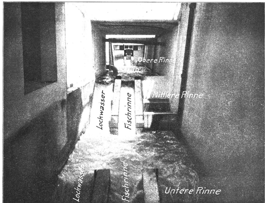
Abb. 14. E.-W. Augst. Oberer Lauf der Deniltreppe.
