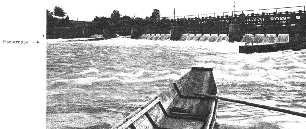
Abb. 43. Elektrizitätswerk Ruppoldingen. Ansicht des Stauwehres von unten mit Fischtreppe auf dem rechten Ufer.
