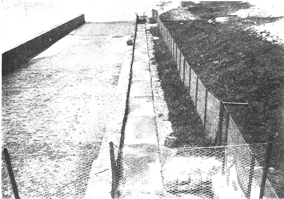
Abb. 39. Stauwehr des Elektrizitätswerks Hagneck. Fischstiege auf dem rechten Ufer, von oben gesehen.
