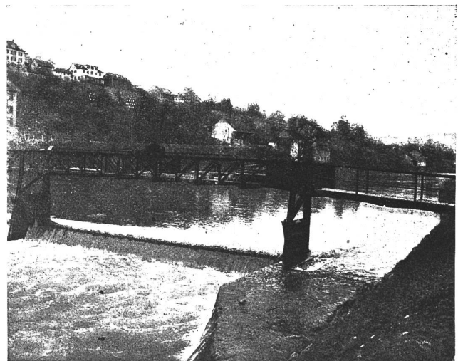
Abb. 78. Wasserkraftanlage der A.-G. Baumann, Höngg. Ansicht des Wehres von unten mit Fischpass am linken Ufer.
