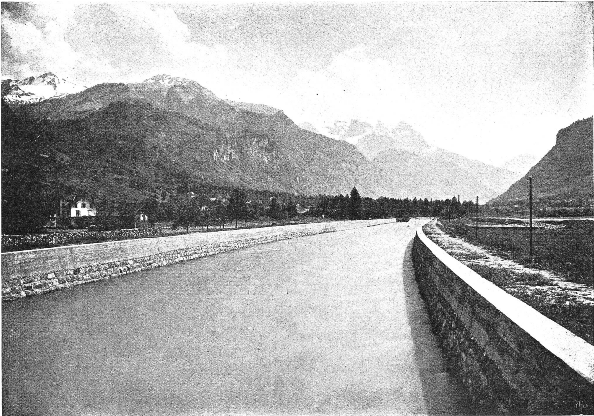
Abb. 100. Korrektion der Engelberger Aa (Strecke oberhalb der Brücke).
