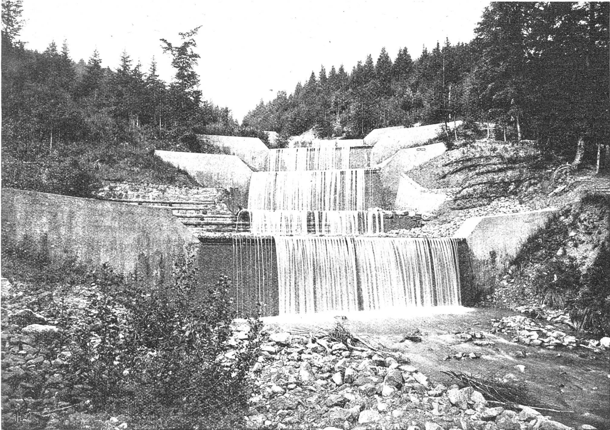
Abb. 98. Verbauung der Gürbe. Druckpartie oberhalb der Einmündung des Maierriesligrabens. Zustand im Jahre 1913 nach dem Ausbau mit Betonsperren.
