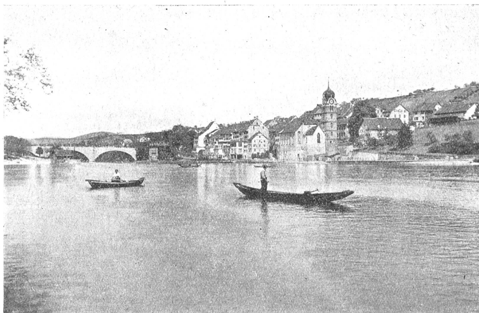
Abbildung 2. Ansicht des gestauten Rheines bei Eglisau, im Hintergrund die neue Brücke.
