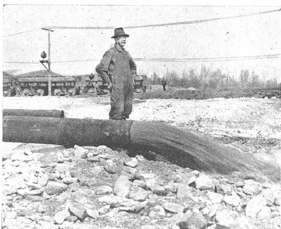
Abb. 14. Austritt der Schwemm-Masse beim Englewood-Damm. Im Vordergrund grösste, von Druckwasser noch mitgeführte Steine.
