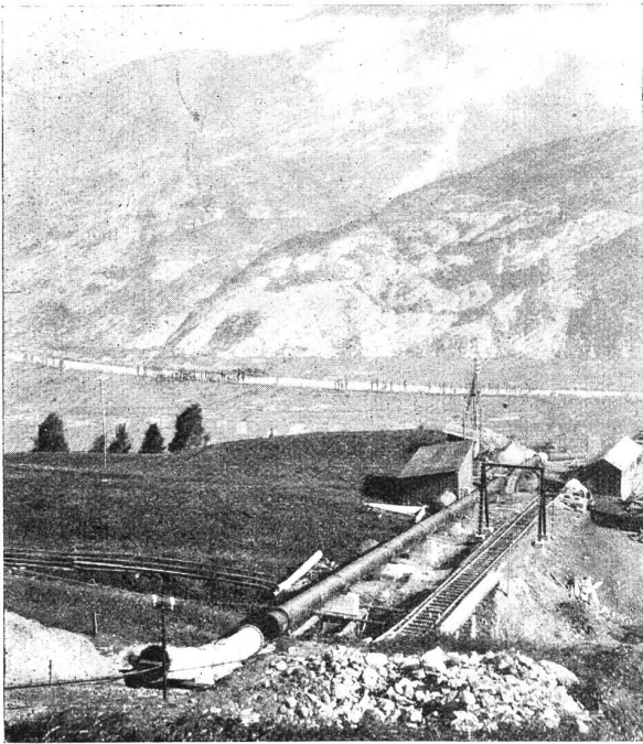
Abb. 9. Illsee-Turtmann. Druckleitung Oberems-Turtmann.
