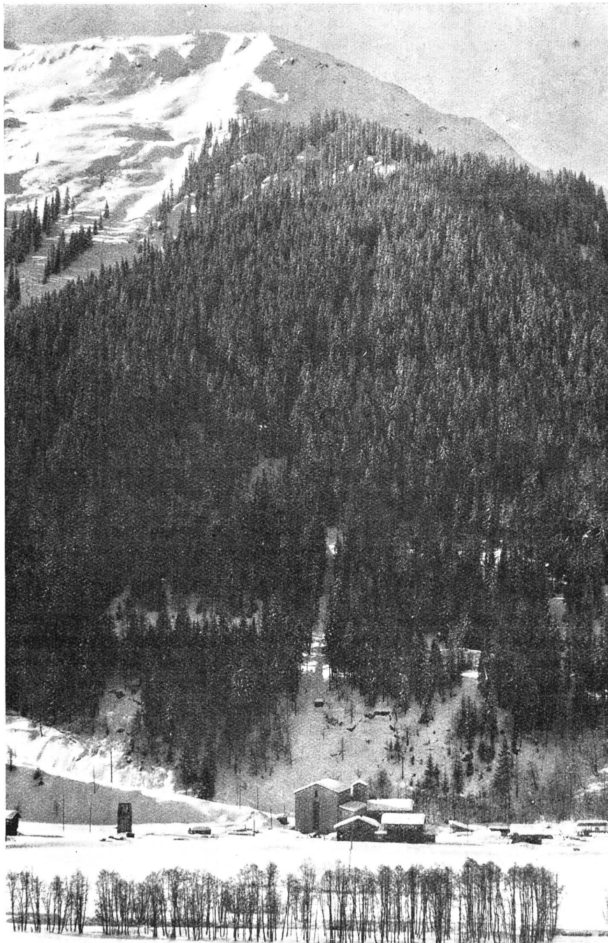
Abb. 36. Klosters. Ansicht der Zentrale und Druckleitungs-Tracé.
