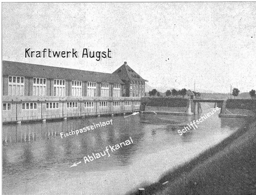
Abb. 1. Eingang zur Schiffschleuse und zum Fischpass beim Kraftwerk Augst von unten gesehen. Die aus der Schleusenammer austretende Lockströmung fñgt sich annähernd tangential in die Turbinenausläufe und lockt so die vor den Turbinen suchenden Fische zum Einstieg in die Schleusenammer.
