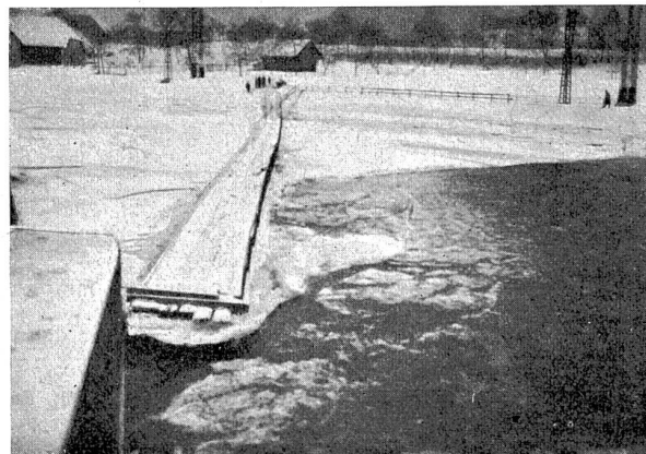
Abb. 4. Elektrizitätswerk Wangen. Unter der Eisdecke auftauchende Grundeismassen bei der Zentrale.
