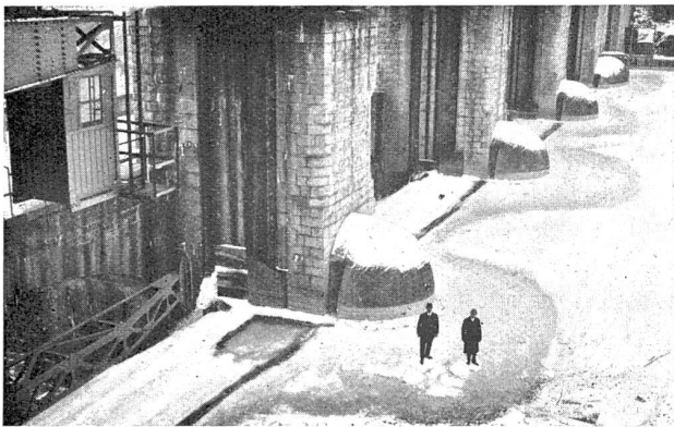
Abb. 39. Kraftwerk Laufenburg. Blick vom Oberwasser gegen das Wehr. Februar 1929.
