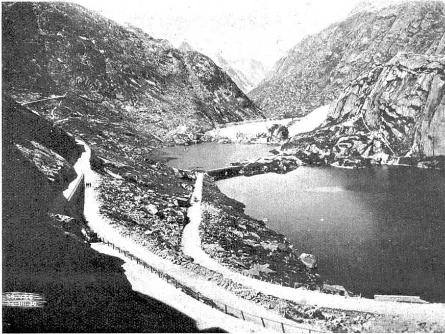
Abb. 3. Vorn die beiden bisherigen Grimselseein, hinten der neue Stausee auf Kote 1868, dazwischen das alte Hospiz vor dem Einstau.
