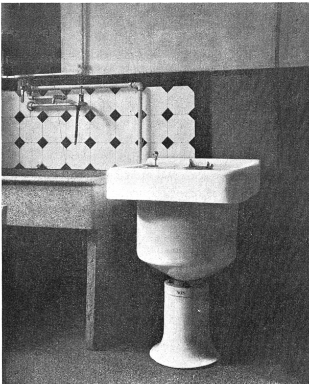
Abb. 23 «SOS» Geschirrwashmaschine mit Anschluss an Boiler.
