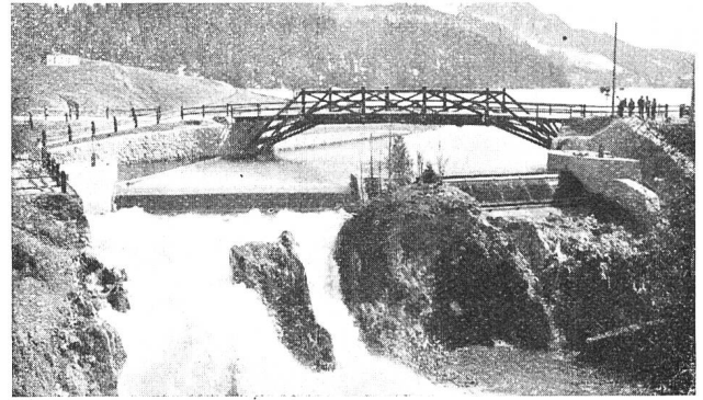
Abb. 2. Elektrizitätswerk St. Moritz. Zentrale Islas. Dachwehr am Innfall. 2 Wehre je 14,0 m breit mit 1,2 m Stauhöhe.
