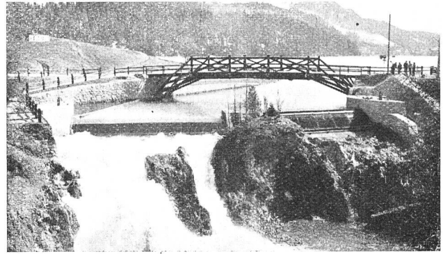
Abb. 2. Elektrizitätswerk St. Moritz. Zentrale Islas. Dachwehr am Innfall. 2 Wehre je 14,0 m breit mit 1,2 m Stauhöhe.
