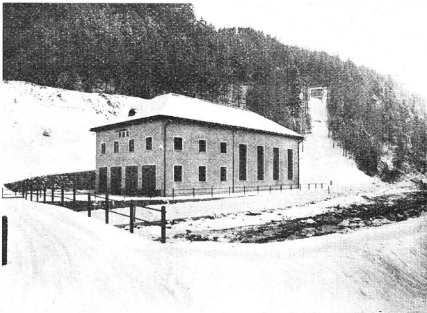
Abb. 5. Elektrizitätswerk St. Moritz. Ansicht der Zentrale „Islas“.
