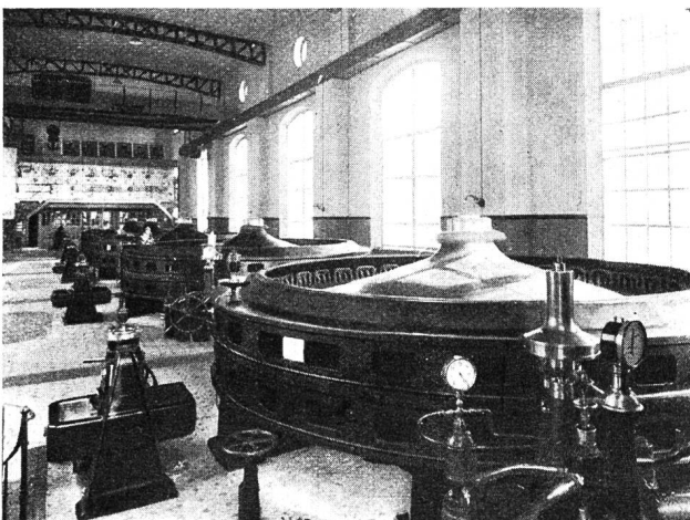
Abb. 3. Elektrizitätswerk Hagneck. Inneres des Maschinenhauses vor dem Umbau. Ansicht gegen den Eingang (Osten).
