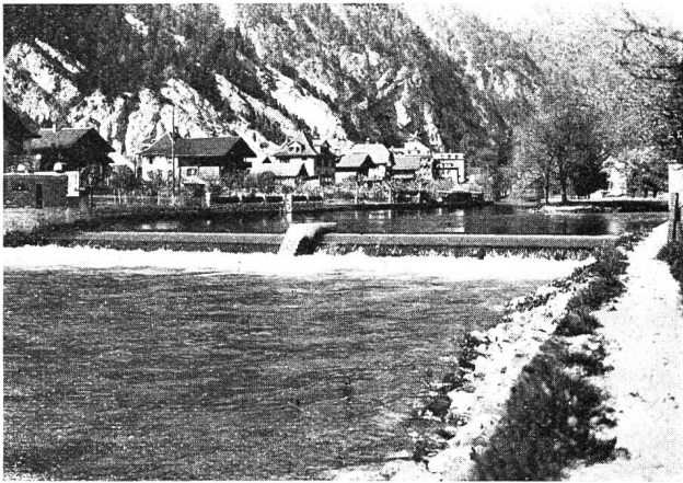
Elektrizitätswerk Interlaken. Dachwehr in der Aare zwischen Briener- und Thunersee.
