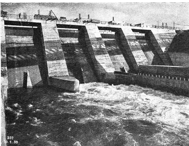
Abb. 7. Kraftwerk Wettingen. Ansicht des Wehres von der Unterwasserseite.
