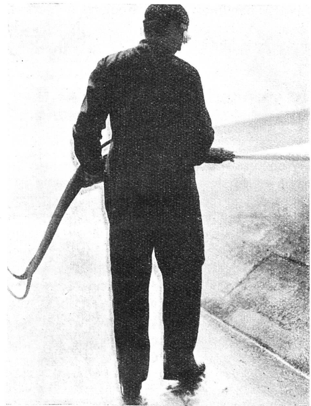
Abb. 10. Versuche zur Aufbringung bituminöser Beläge nach dem Torkretverfahren, System Baurat Reiner, Berlin.
