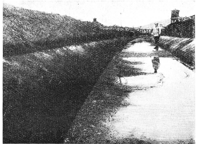
Abb. 7. Ein Teilstück des Kanals in Abb. 6 nach 3/4 jähriger Betriebszeit. Man erkennt, daß an einigen Stellen Pflanzen durch die Decke hindurchwachsen.
