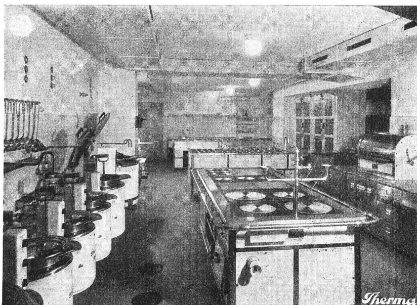
Abb. 8 Gesamtüberblick der Küche mit Kippkesseln links
