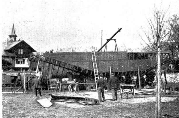
Abb. 4. Zürichsee-Fähre Meilen-Horgen. Mittelschiff beplattet.
