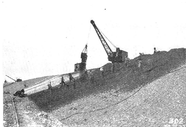
Abb. 6. Kraftwerk Klingnau. Linksseitiger Stausedamm unterhalb Gippingen, Wasserseite. Einbringen und Verteilen des Lehmcs für die Dammabdichtung mittelst Greifer und Handarbeit auf der Böschung als Vorbereitung für die Walzung.
