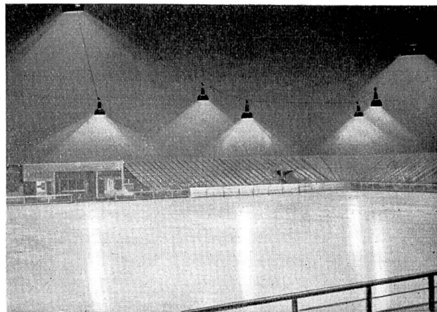
Abb. 29 Beleuchtung der Basler Kunsteisbahn.
