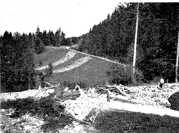
Abb. 7 Der Brandbach bei Hütten. Zerstörte Durchlässe und Geschiebeablagerungen oberhalb der Säge Passages démolis et dépôts de galets en amont de la scierie près Hutten
