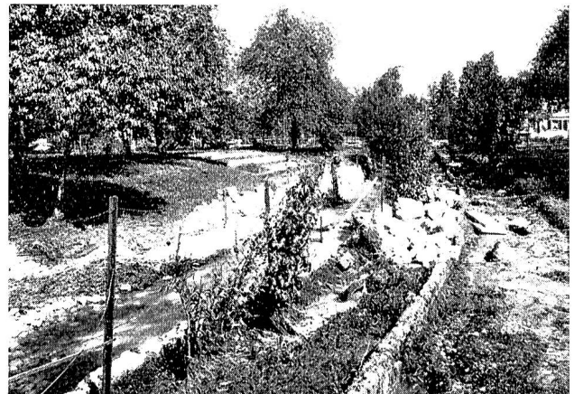
Abb. 10 Der Mühlebach bei Richterswil. Sohlenerhöhung und Geschiebeüberführung im unteren Dorfteil Encombrement du lit et dépôts de galets du «Muhlebach» près Richterswil (bas-village)
