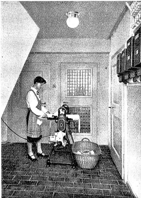
Abb. 5 Keller gang: Die elektrische Wäschemange befindet sich im Keller gang und wird dort vom Haushalt-motor angetrieben; rechts das Zähler-Tableau.
