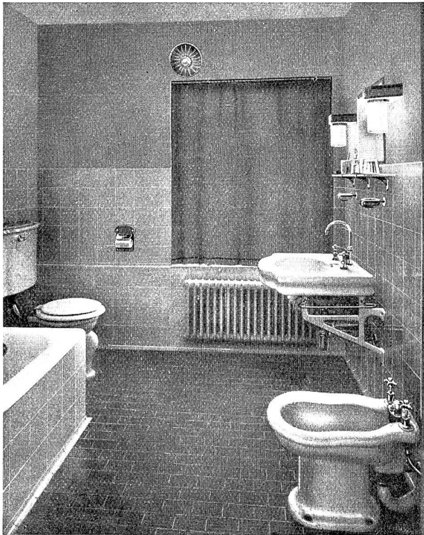
Abb. 3 Badezimmer. Man beachte in der Mitte oben einen der drei «Strahler» deren Wärmestrahlen sich auf den Platz vor der Badwanne richten. Die beiden Lampen links und rechts vom Toilettenspiegel dienen auch der allgemeinen Raumbeleuchtung.
