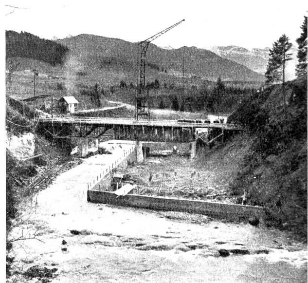
Abb. 18 Etzelwerk Staumauer. Fundamentaushub. 6. Dezember 1934
