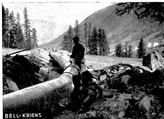
Abb. 59 Elektrizitätswerk Samaden Montage der Druckleitung zwischen Pontresina und Alp Priima.
