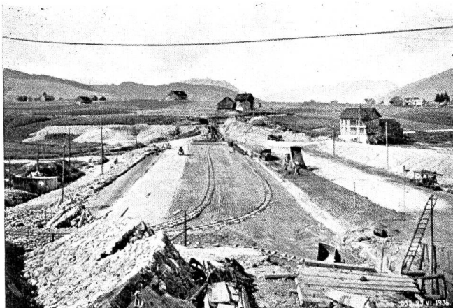
Abb. 85 Hühnermattdamm. Bauzustand am 25. Juni 1936.
