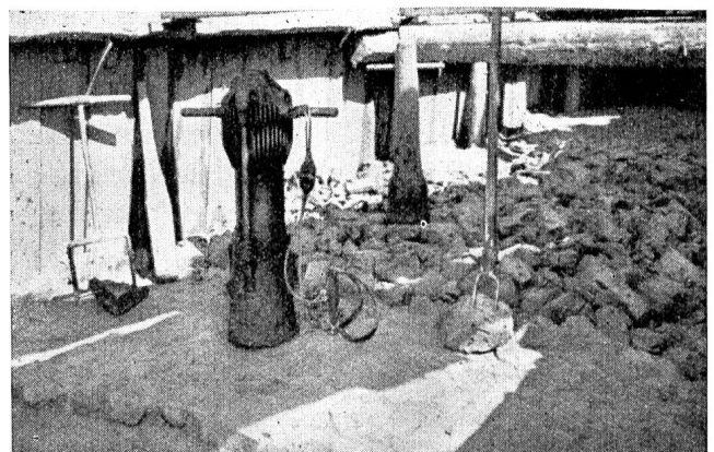
Abb. 83 Hübnermattdamm. Lehmkern im Schlitz.
