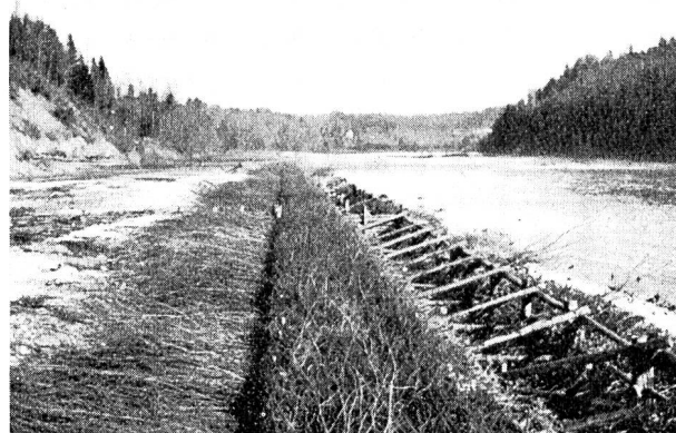
Abb. 20 Thur oberhalb Bischofszell 1937. Wolfsche Wand. Fixierung des Leitwerkes. Eidg. Oberbauinspektorat.
