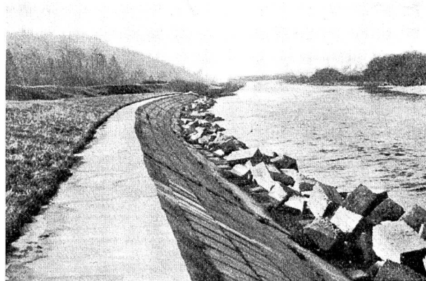
Abb. 19 Thur bei Amlikon 1931. Betonplatten und Betonblockvorgrund. Eidg. Oberbauinspektorat.
