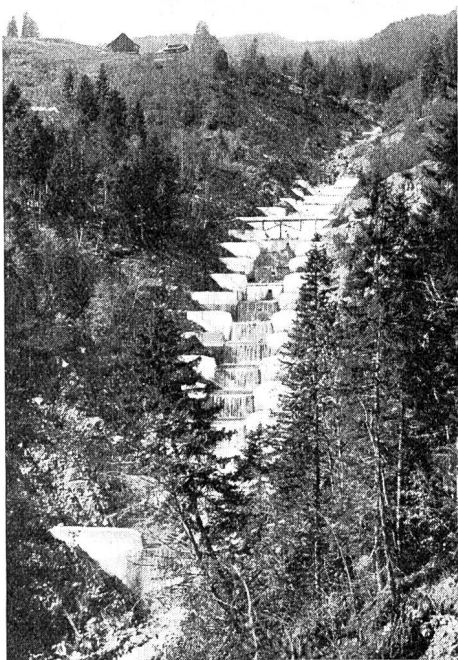
Abb. 18 Mettenlani bei Giswil. Eidg. Oberbauinspektorat.
