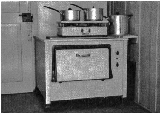
Fig. 79 Elektrischer Bauernbackofen mit aufmontiertem 2-Platten-Réchaud. Four électrique de campagne surmonté d'un réchaud à 2 plaques.
