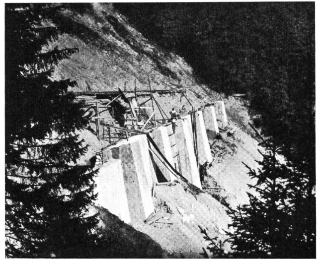
Abb. 7 Lehnenmauer bei Fadiel im Bau.
