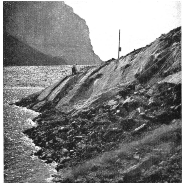
Abb. 4 Stauesee Bannalp, Abdichtungsarbeiten (7. Juli 1938).
