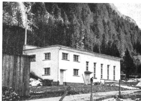
Abb. 10 Kraftwerk Tagenstal, Ansicht der Zentrale.
