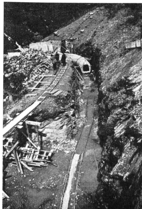
Abb. 5 Kraftwerk Tagenstal, Zuleitungsstollen im Bau.
