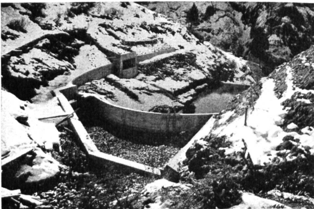
Abb. 4 Kraftwerk Tagenstal, Gesamtansicht der Fassung mit Ueberlauf, Blick in den provisorischen Weiher.
