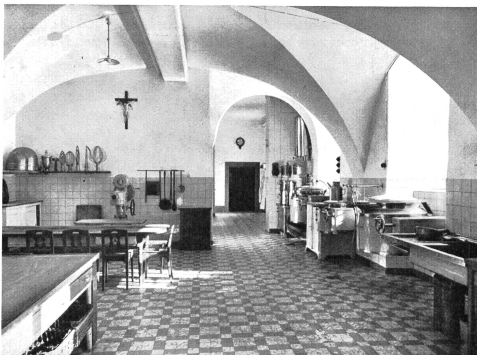
Fig. 29 Klosterküche Engelberg. Kippkessel, Autoklav und Kaffeemaschine.
