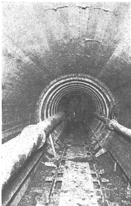
Abb. 19 Ausbetonierter Stollen mit eiserner Schalung.
