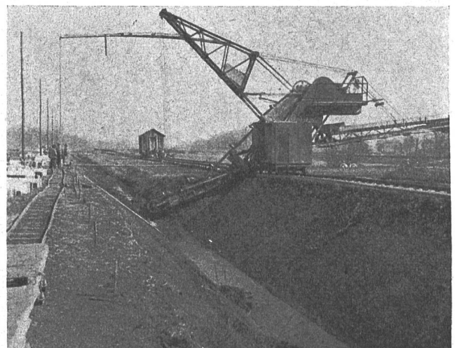
Abb. 15 Eimerkettenbagger auf Geleise mit Transportband.
