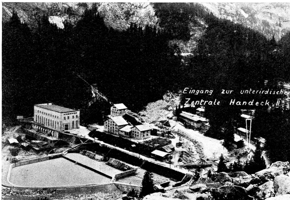
Abb. 1 Baustelle der Zentrale Handeck II. Links: Zentrale Handeck I und Maschinistenwohnhäuser; im Vordergrund links Ausgleichsweiher für den Wasserzufluss zum Kraftwerk Innertkirchen.
