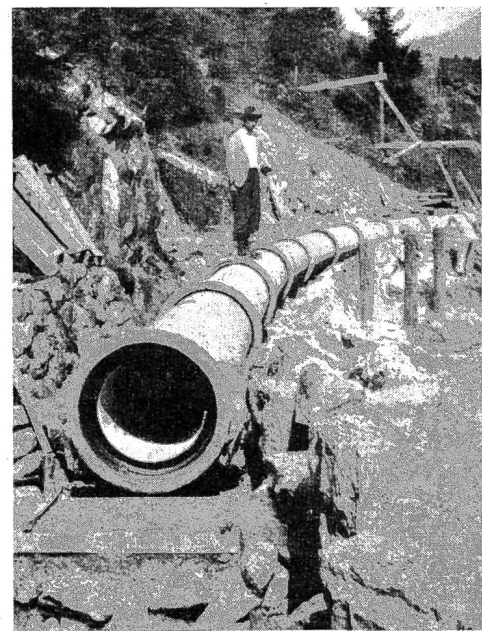
Abb. 13 Kraftwerk Luchsingen II. Hangzuleitung. Doppelglockenmuffenrohre \varnothing 600 mm.
