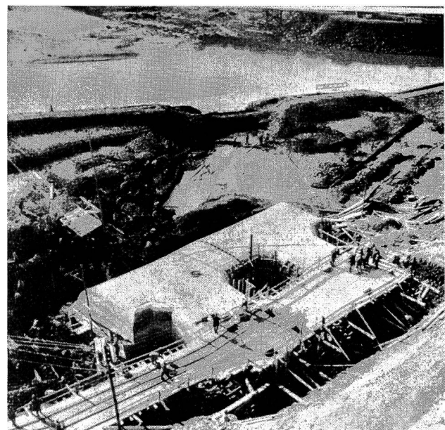
Abb. 16 Schutzbauwerk vor den beiden linksseitigen Grundablässen der Möhne-Staumauer.
