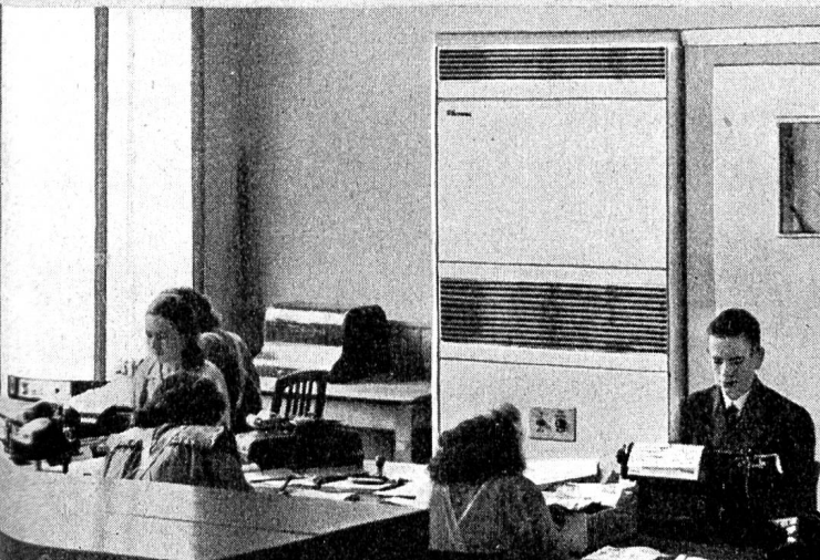
Klimagerät in einem Büro
