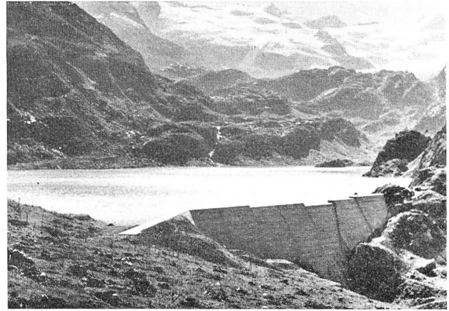
Stauanlage Mattenalp unterhalb des Gauligletschers im Urbachtal
