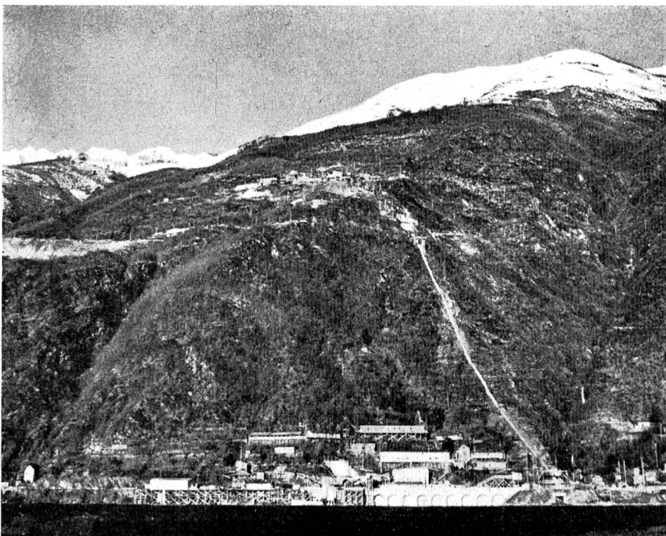
Abb. 12 Baustellen Verbano, Ansicht vom See
