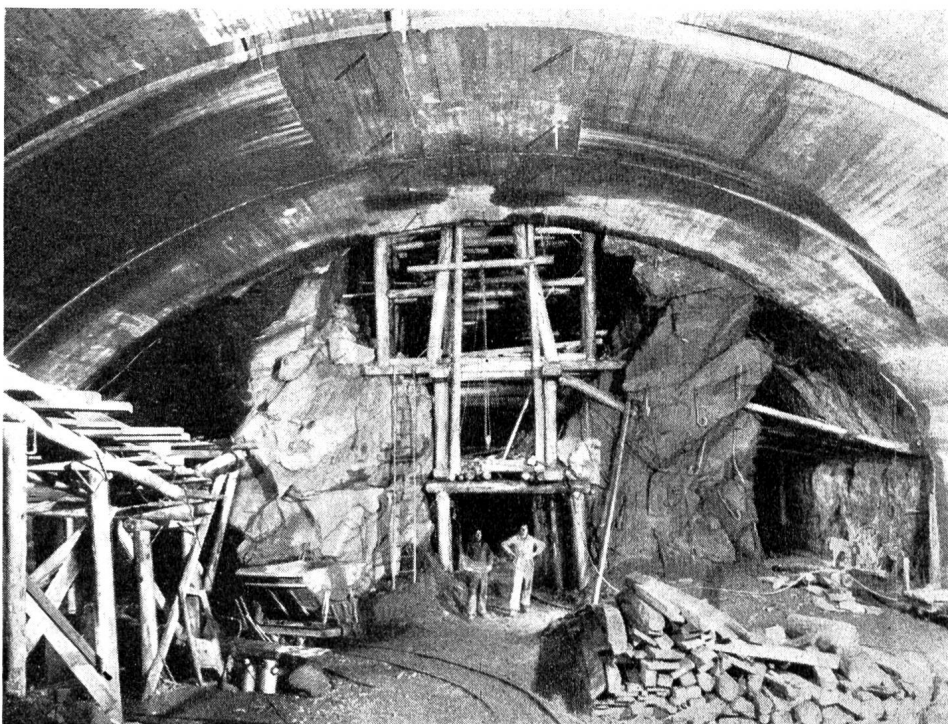
Abb. 10 Zentrale Verbano, Gewölbe der Maschinenkaverne
