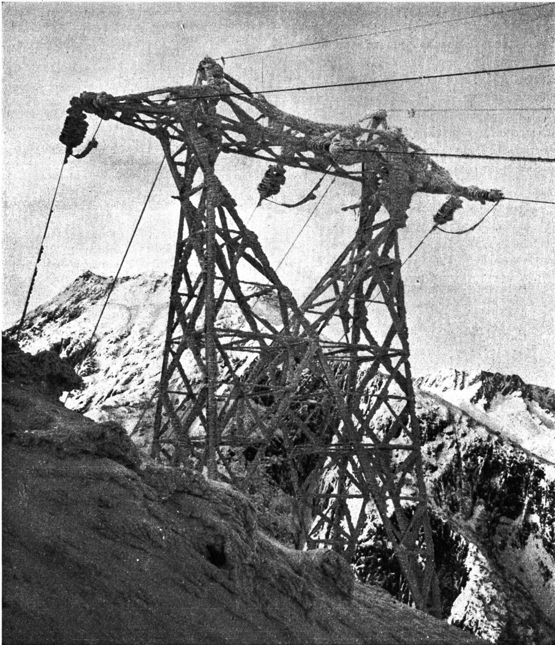
Abb. 15 Abspannmast der Gotthardleitung
