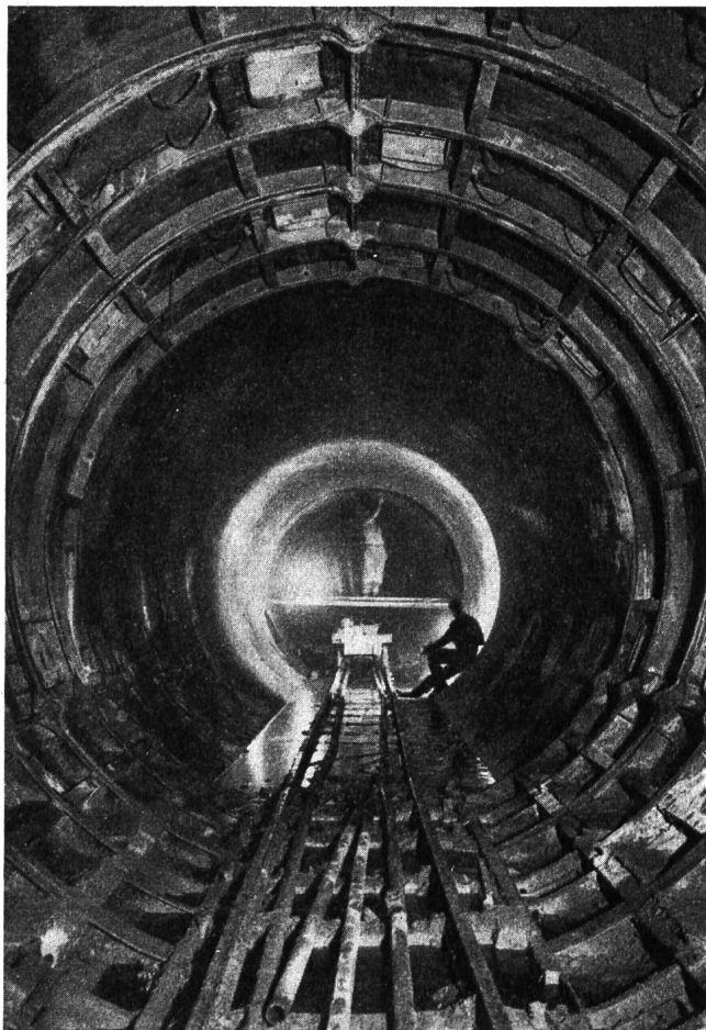
Abb. 25 Druckstollen des Kraftwerkes Verbano, Betonierung und Injektionen des Mantels
