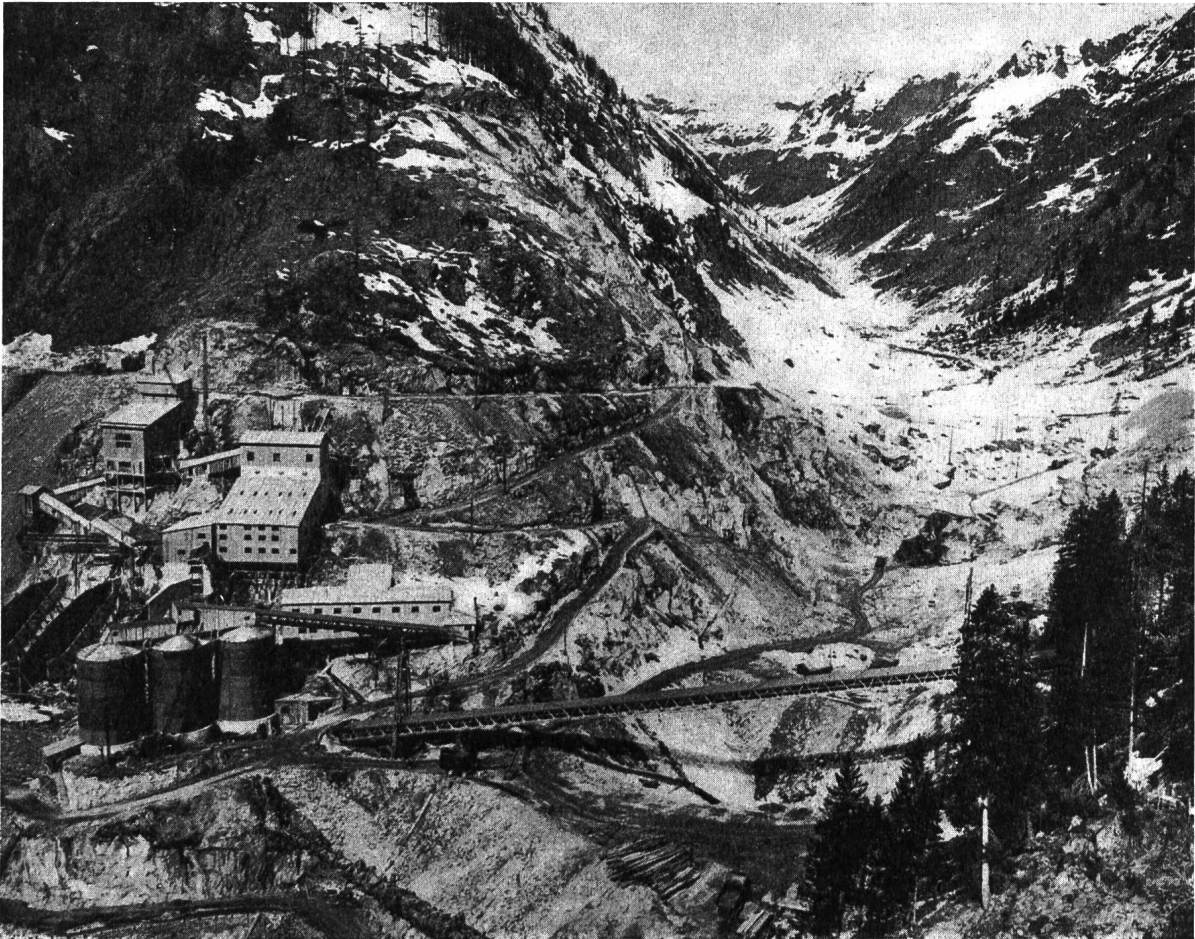
Abb. 5 Installationen für die Staumauer Sambuco, Bauzustand April 1953. Blick gegen Passo di Naret
