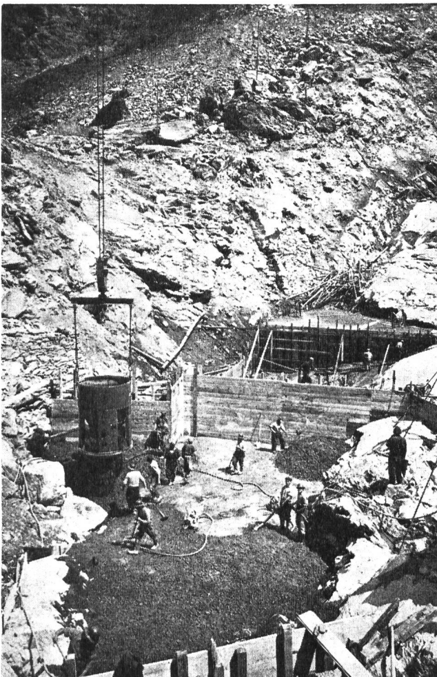
Abb. 8 (oben) Erste Betonblöcke und Fundament linke Flanke
