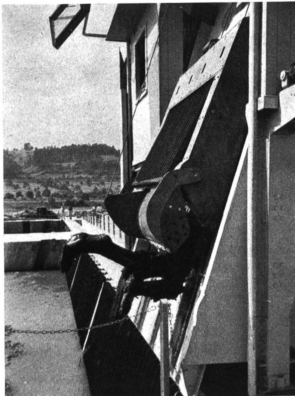
Rechenreinigungsmaschine mit neuer patentierter Greiferharke ausgerüstet
