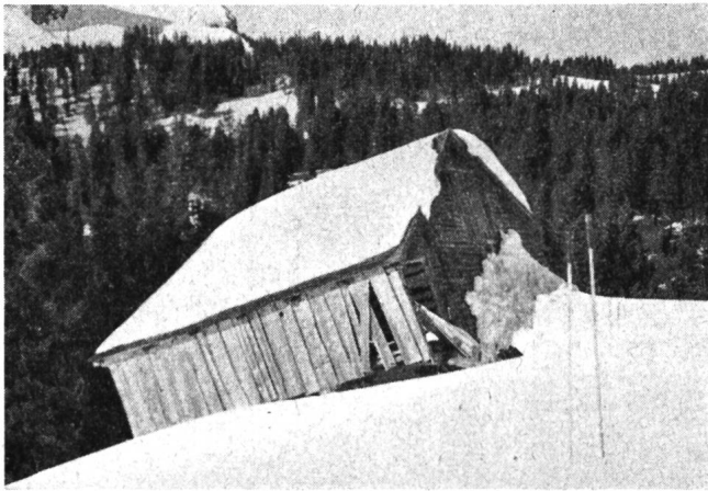
Abb. 8 Durch Kriechen (Gleiten) der Schneedecke verschobener Stall, Gulmen bei Amden, 22. Februar 1953 (Photo: R. Haefeli)
