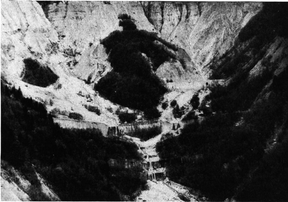
Abb. 1 Schesa-Oberlauf. Blick in den Bruchkessel mit oberer Sperrenstaffel; im Hintergrund rechts Sperre 107 in km 1.50 (Hölltobel), davor die 21 m hohe, 197 m lange Sperre 88 in km 42.68, bei der die Sohle schon um 70 m gehoben ist.
