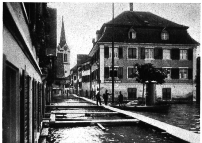
Abb. 1 Überschwemmung in Berlingen (Untersee) durch das Hochwasser vom Juni 1926.
