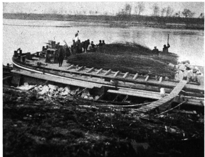
Abb. 1 Eine Senkbrücke zur Erstellung von Senkwürsten und Faschinen (Aufnahme aus dem Jahre 1937).
