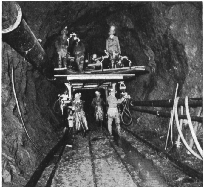
JOY-Bohrwagen mit 5 Bohrhämmern auf Lafetten im Druckstollen Gd. Dixence-Fionnay
